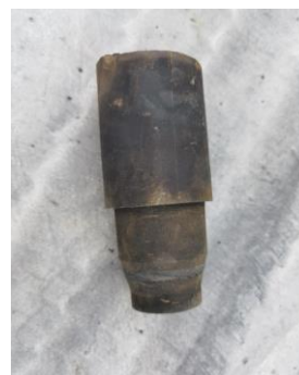
原备用的堵头因老化发硬，且现状不够理想，无法使用，要重新制作
