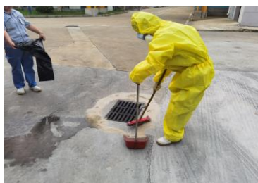
将围堵雨水井的黄沙清理干净
