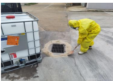
同时因泄漏点靠近雨水井，员工立即用沙子将雨水井围起来，防治废液流入雨水井
