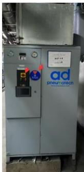
员工巡检时发现2号冷干机漏气，立即关机、关闭电源并挂维修牌
