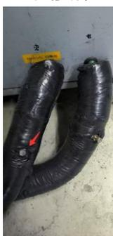
确认排空冷干机管道内压力，开始维修
