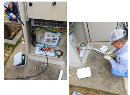
更换不好的信号线后试运行，移送泵启动正常
