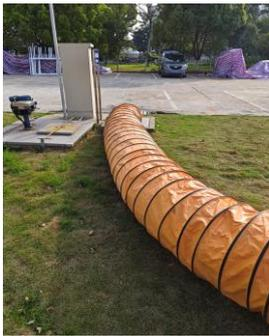
根据安全操作规定，作业前先用鼓风机对积水井内进行通风半小时
