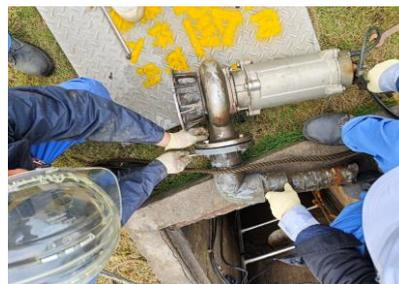
连接处经过修理后不再漏水，将泵恢复原位，经测试，移送泵正常运行
