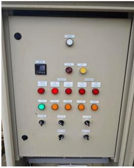
员工点检时发现雨水积水井移送泵启动异常，经查可能是信号线不好
