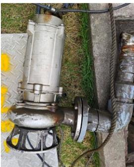
试运行是发现移送泵法兰链接处漏水
