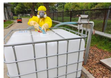
员工将集水井里的废液抽到耐腐蚀的容器中，交由保全课到污水处理场处理
