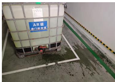
化学品仓库硫酸吨桶阀门没关好发生泄漏
